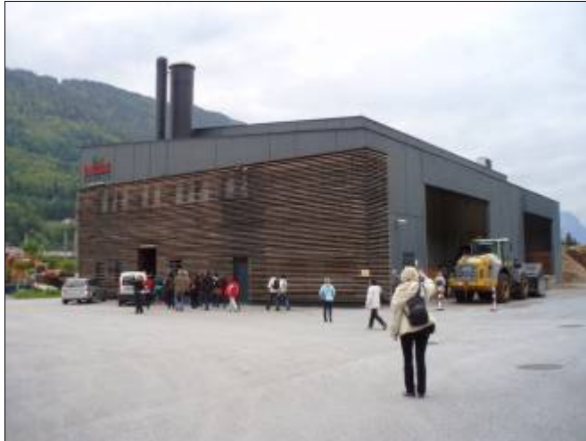
Bioenergielaitos Bio Energie Pongau.
